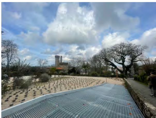
Adaptação do jardim dos cheiros (espaço adjacente ao parque de estacionamento) a jardim acessível, com a colocação de uma rampa metálica de acesso entre o caminho exterior e o piso do jardim, por forma a permitir a sua utilização eventual como zona de estacionamento de veículos.
