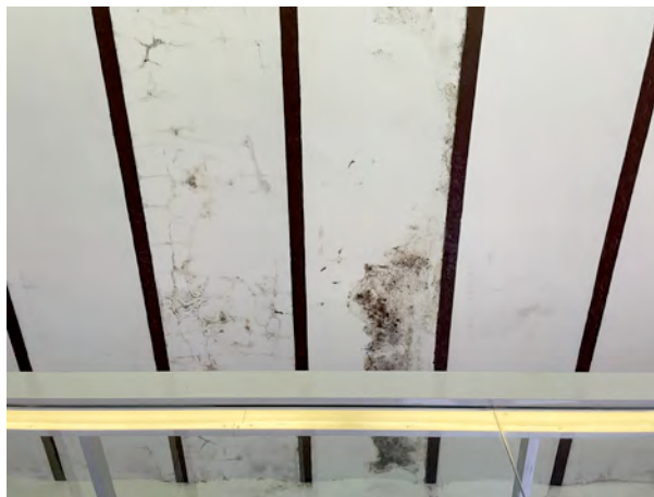
Palácio das Cocheiras, imagens das infiltrações no interior da bilheteira antes da obra de recuperação e pintura.
