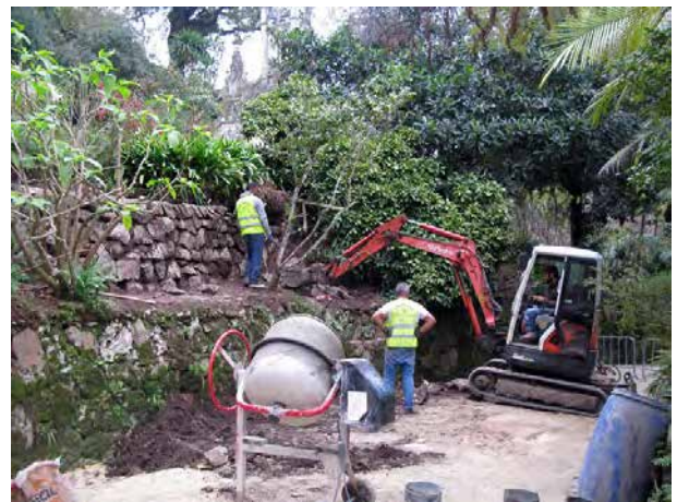
Fotos à direita: recuperação do muro no caminho de acesso da Capela ao portão de saída (canteiro superior)
