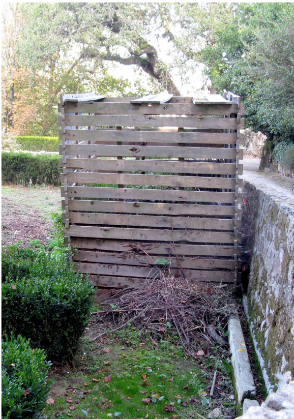
Foto 1: Estrutura de palco no Lago da Gruta do Labirinto, em que é patente o apodrecimento da madeira.
