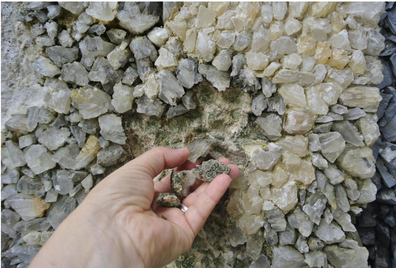
Bastante degradado no espaço de um século, alterado por intervenções pouco criteriosas, este revestimento implicou ao longo do ano de 2014 um restauro minucioso dos embrechados com a reposição do desenho com material conforme o original e a tardoz, uma limpeza das colonizações biológicas com aplicação de biocida. Foram ainda reproduzidas em mármore a bica da fonte, conforme características de origem e uma tina de decantação e alimentação da Fonte.
