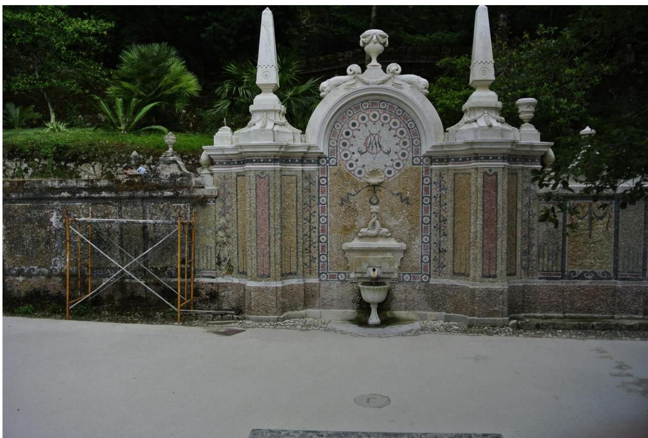
Este conjunto paisagístico sofreu consideráveis desgastes de erosão e deformações estruturais, sobretudo originados pela ação mecânica do crescimento de uma árvore de grande porte na sua proximidade e pela desagregação de argamassas provocadas por infiltrações e intensa exposição solar.
